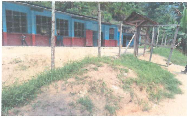
Foto 1: Panorámica del muro perimetral
