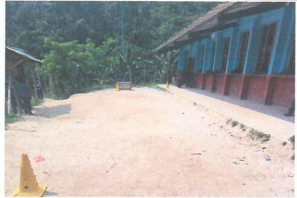
Foto 2: Vista general del patio frontal de la escuela
